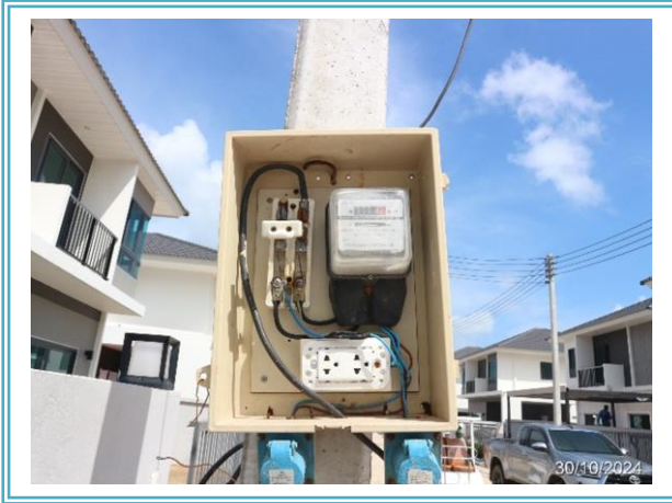
รูปที่ 3.1-44 อุปกรณ์ตัดไฟฟ้าอัตโนมัติ
