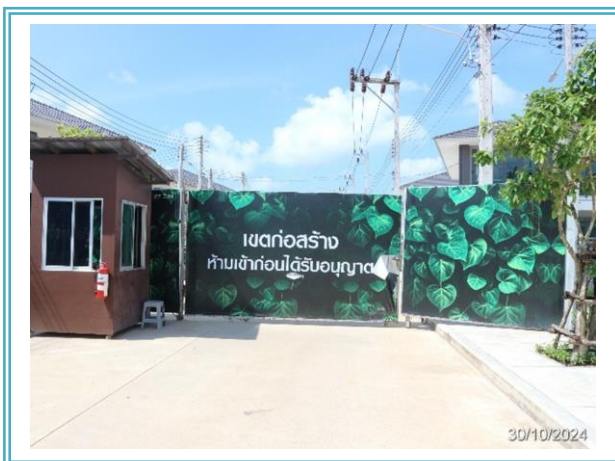
รูปที่ 3.1-6 รั้วผ้าใบกันโซนก่อสร้าง
