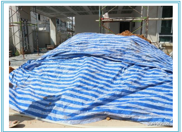
รูปที่ 3.1-3 กองเก็บดินไว้เป็นสัดส่วน และปิดคลุมด้วยผ้าใบ
